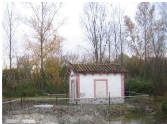
Caseta de control del pastor elèctric
